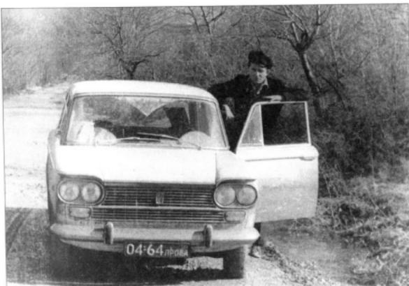
Февраль 1967 г. Испытания тормозов в Крыму (ФИАТ-1500 с барабанными задними тормозами)
